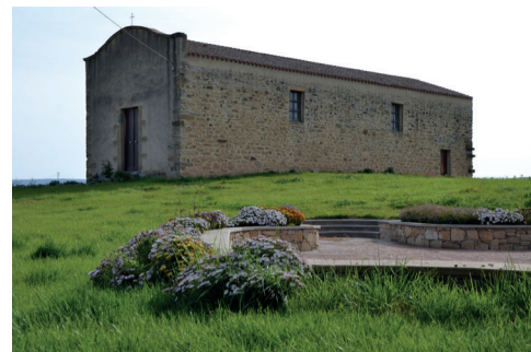
Chiesa Santa Vitalia Via Cagliari (uscita del paese, direzione Curcuris/Ales)
