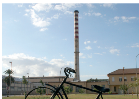
Fonderia di San Gavino Loc. Piscina Linu
